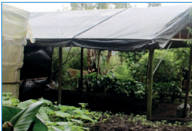
Figura 11. Estructura de bajo costo empleada por un productor para la elaboración de abono orgánico.
